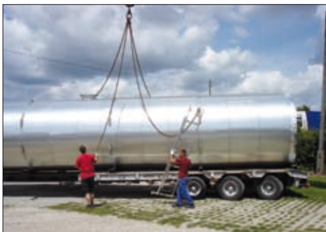
Bild 2: Anlieferung und Montage des Gärbehälters
